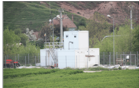
Fig.13. Stația de epurare Șard
